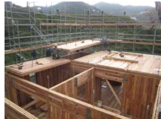
CLTを用いた施工例
